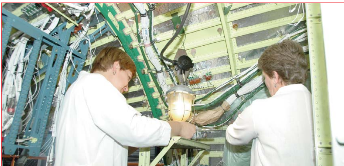
Прокладання електрожгутів у фюзеляжі Ан-178
