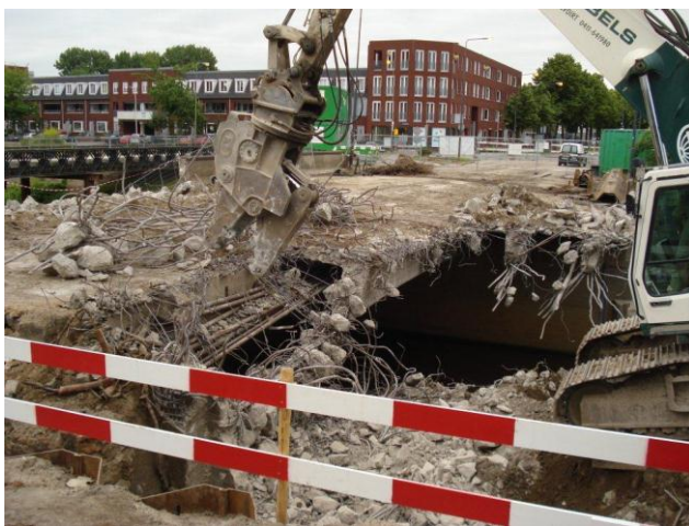
Figuur 8 Sloop van de Bartenbrug (juni 2012)
