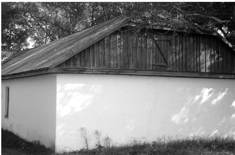
Рис. 28. Левое крыло самой значительной «связной» постройки пос. Гоффенталь – школьного здания (1930 г.). «Связное» пространство снесено при прокладке улицы. При реставрации здания (саманное, обложено силикатным кирпичом) сохранена полувальмовая конструкция крыши, типичная для материнской ремесленно-аграрной колонии Кратцке и характерная для вернакуляра с. Октябрьского. Фото автора, 2009 г.
