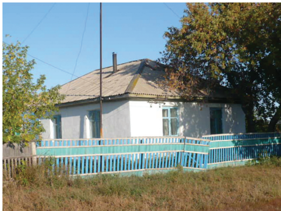
Рис. 35. Типовой кирпичный «совхозный» дом на двух хозяев (построен в середине 1960-х гг.) – основа жилого фонда с. Павловки (бывш. Шендорфск). Фото автора, 2009 г.
