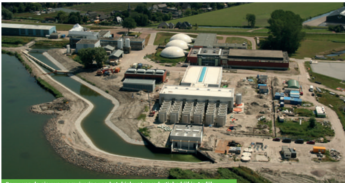
Bouw van de nieuwe voorzuivering van het drinkwaterproductiebedrijf in Andijk
