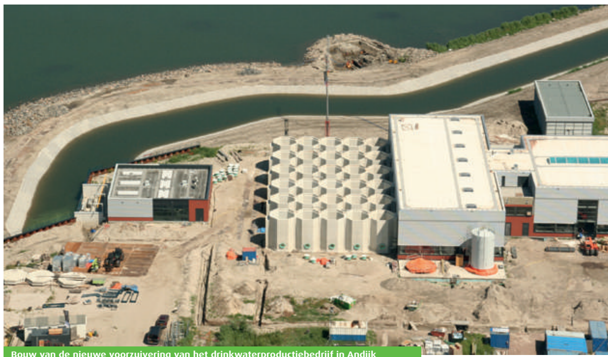
Bouw van de nieuwe voorzuivering van het drinkwaterproductiebedrijf in Andijk
