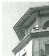
写真1 持ち送り部外観
