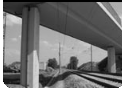
Mosty a inženýrské stavby
