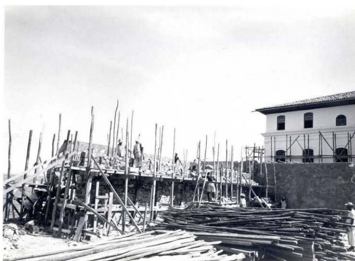
Figura 10 - Recuperação do edifício do Solar do Unhão, Salvador Fonte Arquivo Instituto Lina Bo e P. M. Bardi. Foto W.Ninck
