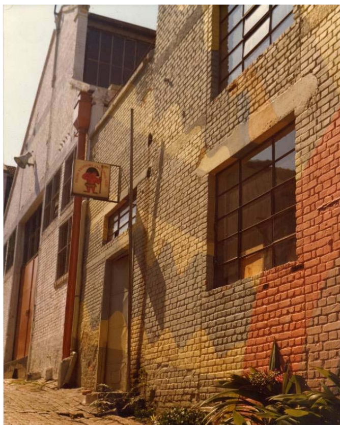
Figura 08 - Atividades no Sesc Pompéia antes do restauro Fonte Arquivo Instituto Lina Bo e P. M. Bardi. S/ Crédito
