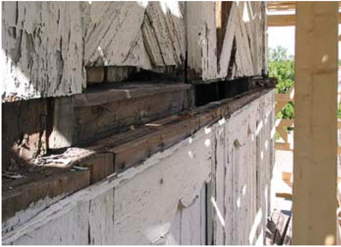
Kruusauksilla on hintansa. Tapulissa vaakalistoitukset olivat kärsineet.
