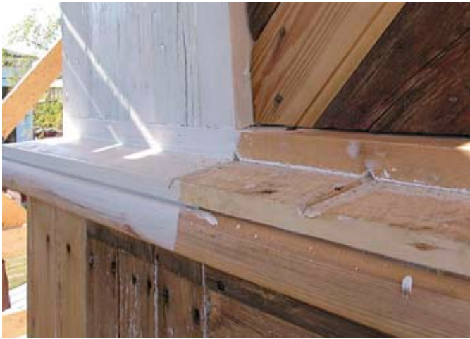
Uusittua ja säilytettyä lomalaudoitusta. Laudat naulattiin takonau-loilla. Vasemmalla lautaseinän jatkamisessa tyypillinen viistoaminen. Laudan reunat on viistetty.
