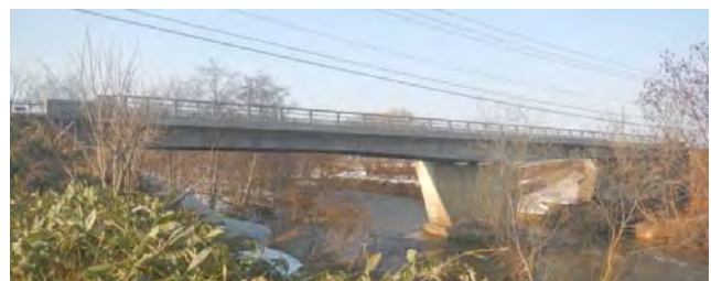
（現況）五ヶ山橋
