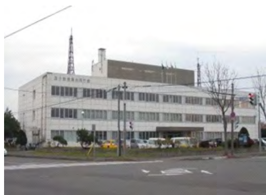
苫小牧港湾合同庁舎 長寿命化改修
