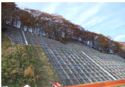
斜面崩落防止対策
