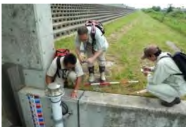
施設の点検（樋門）
