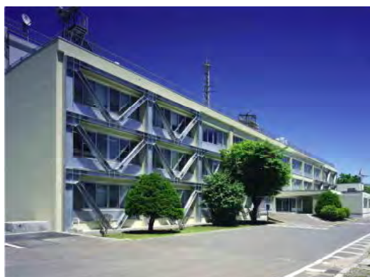
耐震改修工事の事例
