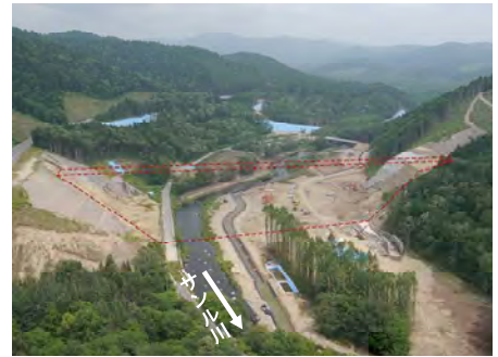
サンルダム（本体工事）
