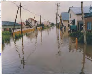
創成川 市街地の浸水状況 (札幌市)
