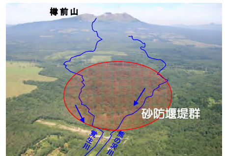
樽前山 おぼつが 覚生川砂防堰堤群の整備
