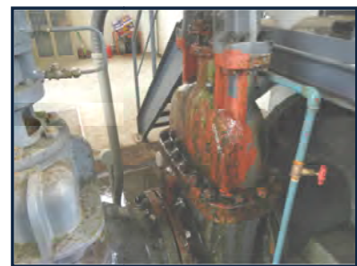
老朽化したポンプからの漏水
