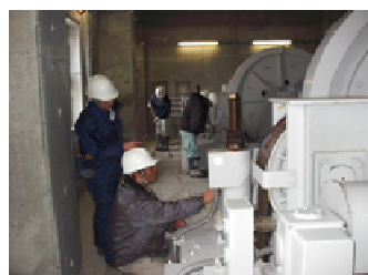
施設の点検（ダムゲート）
