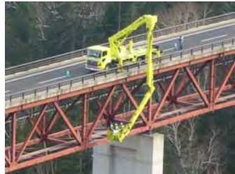
橋梁の点検状況
