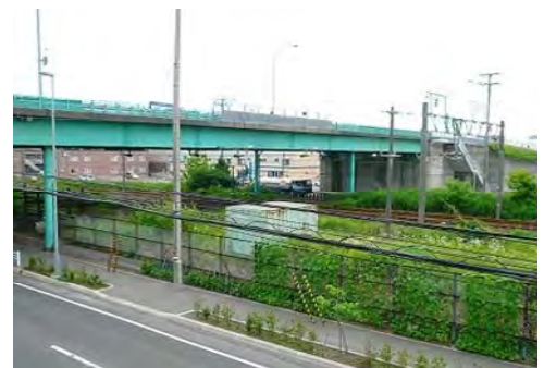
（現況）緑跨線橋
