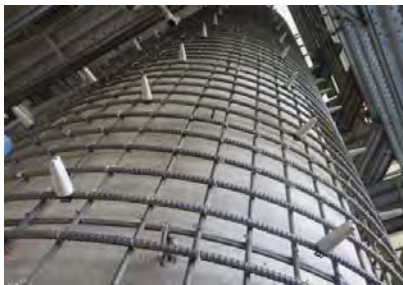
橋脚の耐震補強
