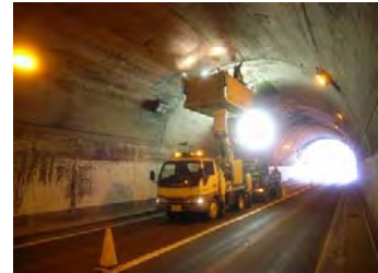
トンネルの点検状況
