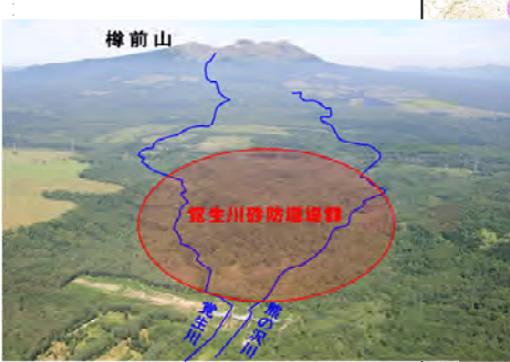
覚生川砂防堰堤群（建設中）
