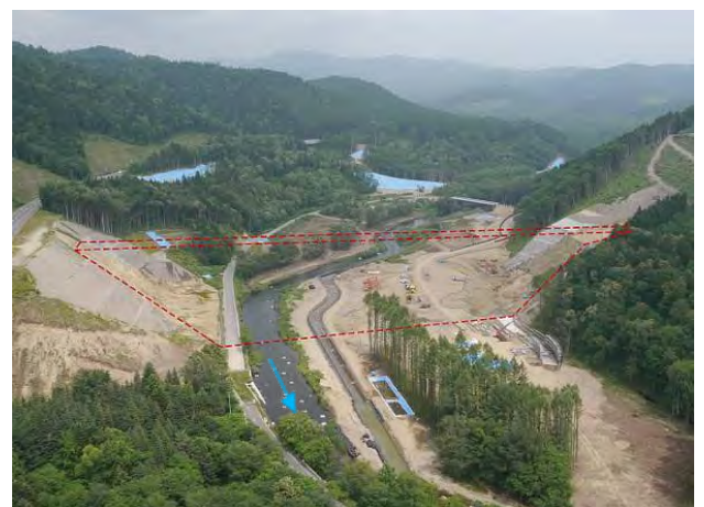
本体工事状況（平成26年7月撮影）
