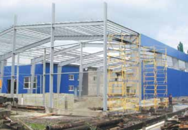
Виробничий цех з обробки металу, змонтований компанією «Інтеко контракшн» у Сумській області
