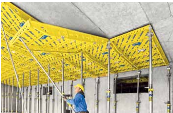
Застосування горизонтальної опалубки Dokadek 30
