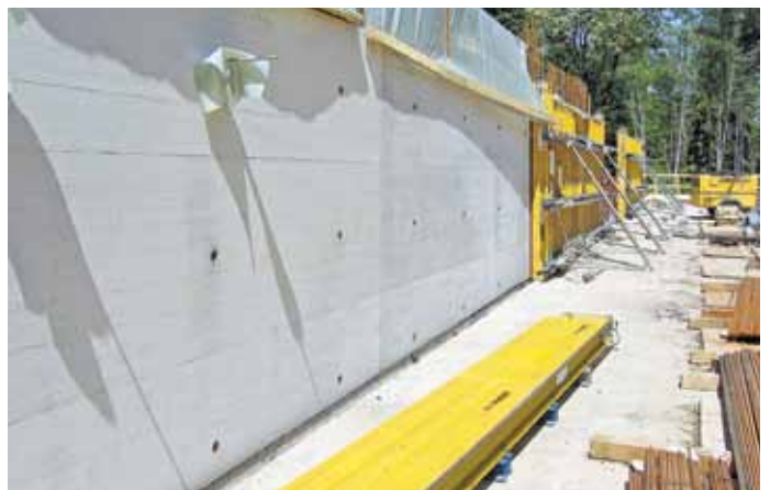
Результат бетонування з використанням плити 3-SO
