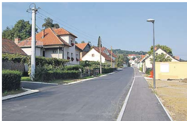
Ivana Kaučiča cesta je prva ulica v Ljutomeru, v kateri so pred 35 leti začeli organizirano graditi kanalizacijo, zato je bila prenova vse infrastrukture več kot potrebna.
