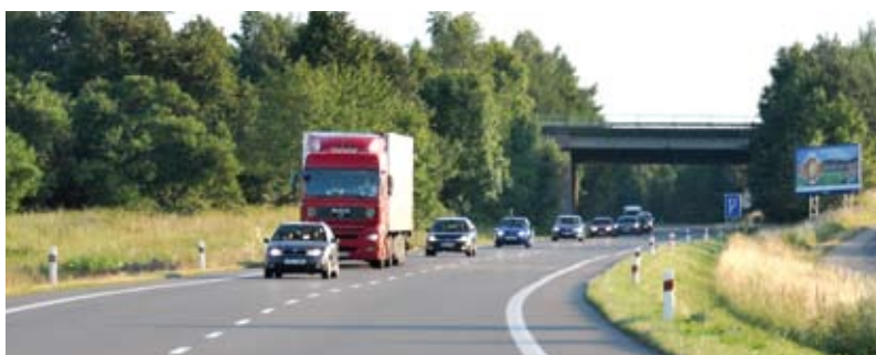
Nadjezd silnice Mirovice–Cerhonice přes I/4
