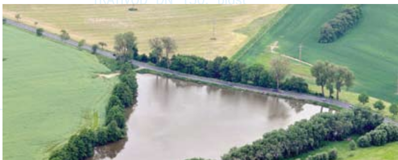
↑ Silnice I/4 na hrázi Nového rybníka
