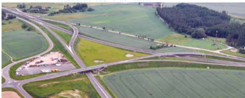
Celkový pohled na mimoúrovňovou křižovatku Nová Hospoda
