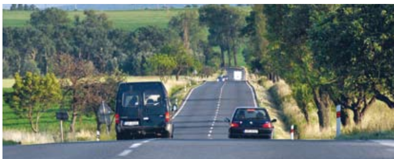
Nepřehledné horizonty od Chraštic po Zalužany
