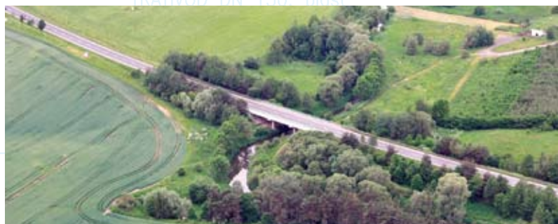
Most přes Lomnici
