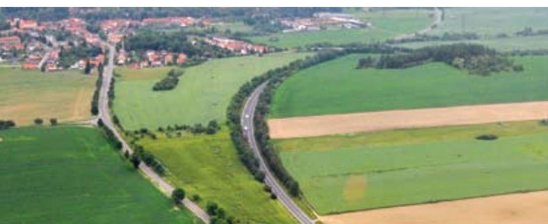
Celkový pohled na obchvat Mirovice
