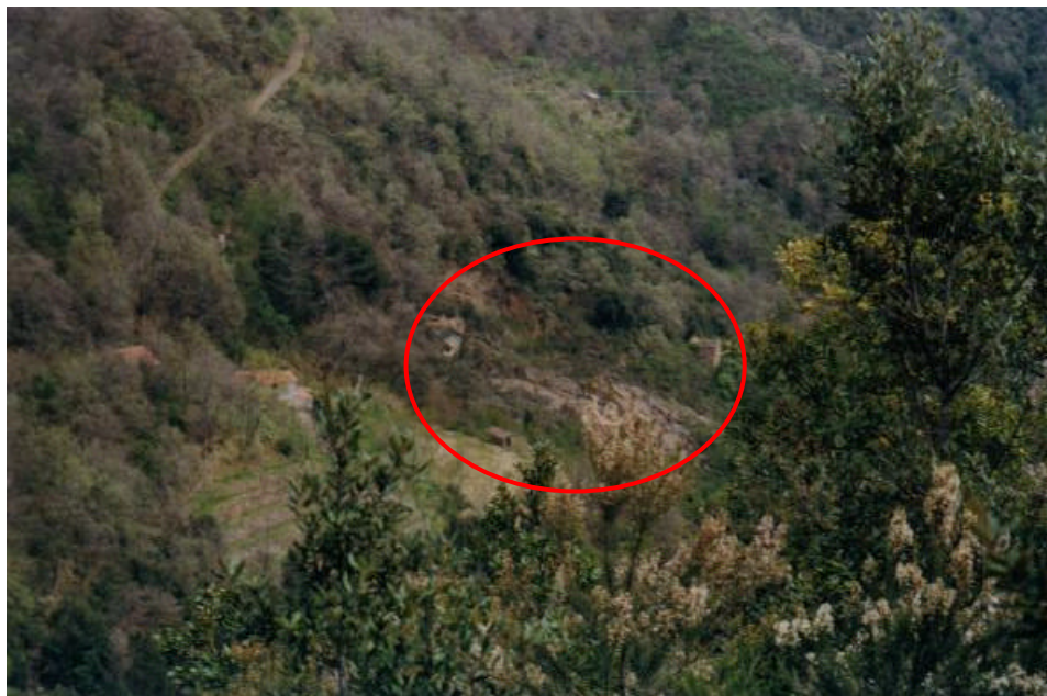
Foto 4 – Frane di crollo in roccia in sponda sinistra del Rio dei Rosci nel fondovalle, presso Marcora
