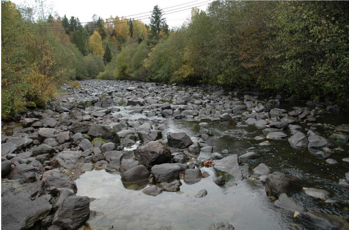
Nedenfor inntaksdammen til Breiskallen kraftverk er det ingen pålagt vannføring. Vannføringen i dag opprettholdes kun som følge av lekkasjer i dammen, noe som gir en svært begrenset vannføring. (Foto: Ola Hegge, FMOP)
