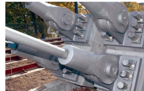
Gabelseilköpfe der Abspannung Süd. Die Zugkräfte werden über Anker in den Baugrund abgeleitet. Ein Gabelkopf wiegt etwa eine halbe Tonne.
