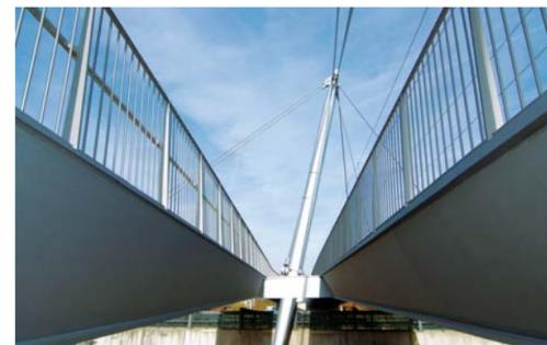
Der schräge Tragmast zwischen den beiden Brückenüberbauten
