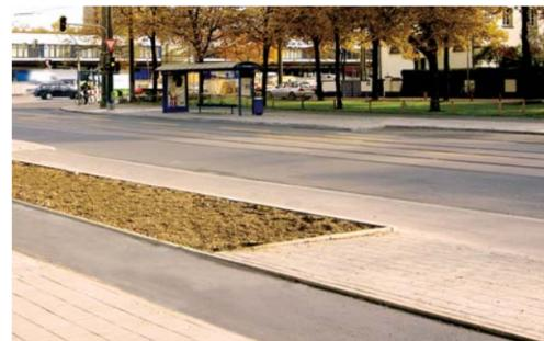
Das neue Straßenprofil mit Gehbahn, Radweg, Baumgraben, Parkbuch und Fahrbahn mit befahrbaren Gleisen wird allen Nutzungsansprüchen gerecht.
