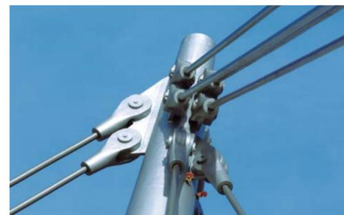
Mastkopf aus Stahlguß mit Seilanschlüssen
