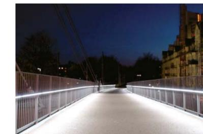
Beleuchtung der Gehwegbrücke mit LED in den Handläufen. Der Energiebedarf für die gesamte Handlaufbeleuchtung entspricht dem eines Fernsehgerätes.
