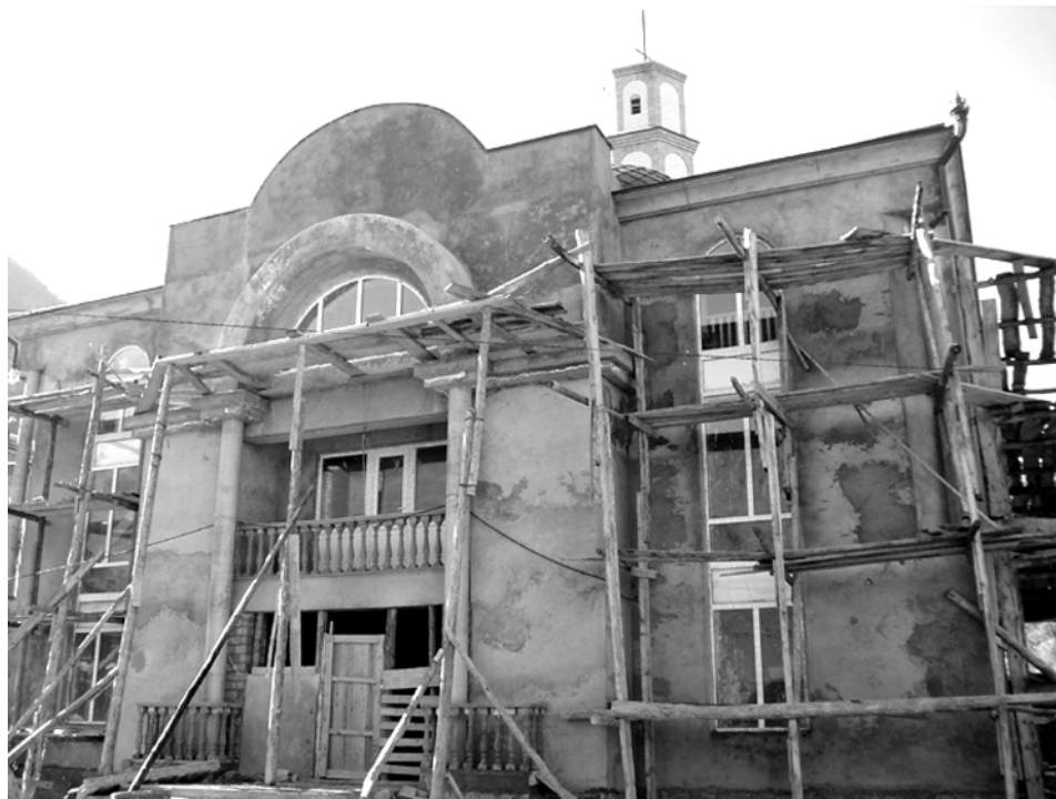
Строительство новой мечети в Хуштаде. Фото автора. 2005 г.
