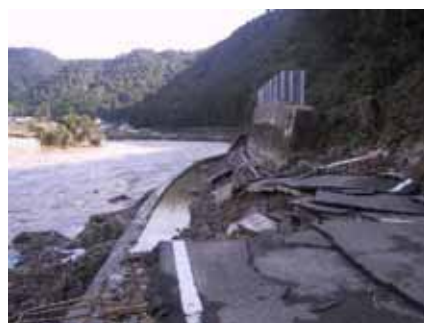
長良川 美濃市上河和地先（平成 16 年）
