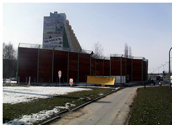
Rys. 19. Realizacja projektu – gotowy ekran przy ul. Opolskiej (Kraków). Wykonawca ekranu – MPRD Warszawa
