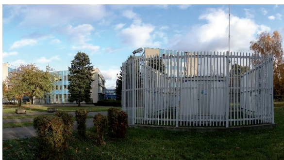
Rys. 8. Stacja Wojewódzkiego Inspektoratu Ochrony Środowiska w Warszawie (wizja lokalna prowadzona przez Instytut Ochrony Środowiska w roku 2009 w ramach przeglądu systemu monitoringu w woj. mazowieckim) (Foto: Archiwum BD)
