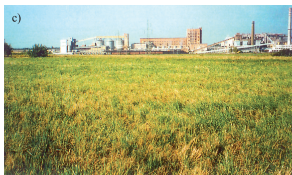
Fot. 4. Rekultywacyjne i kompostowe użytkowanie osadów ściekowych na składowisku odpadów posodowych w Janikowie: a) stan przedrekultywacyjny, marzec 2000 r.; b) stan roślinności w lecie 2001 r.; c) po zbiorze roślin w czerwcu 2002 r.
