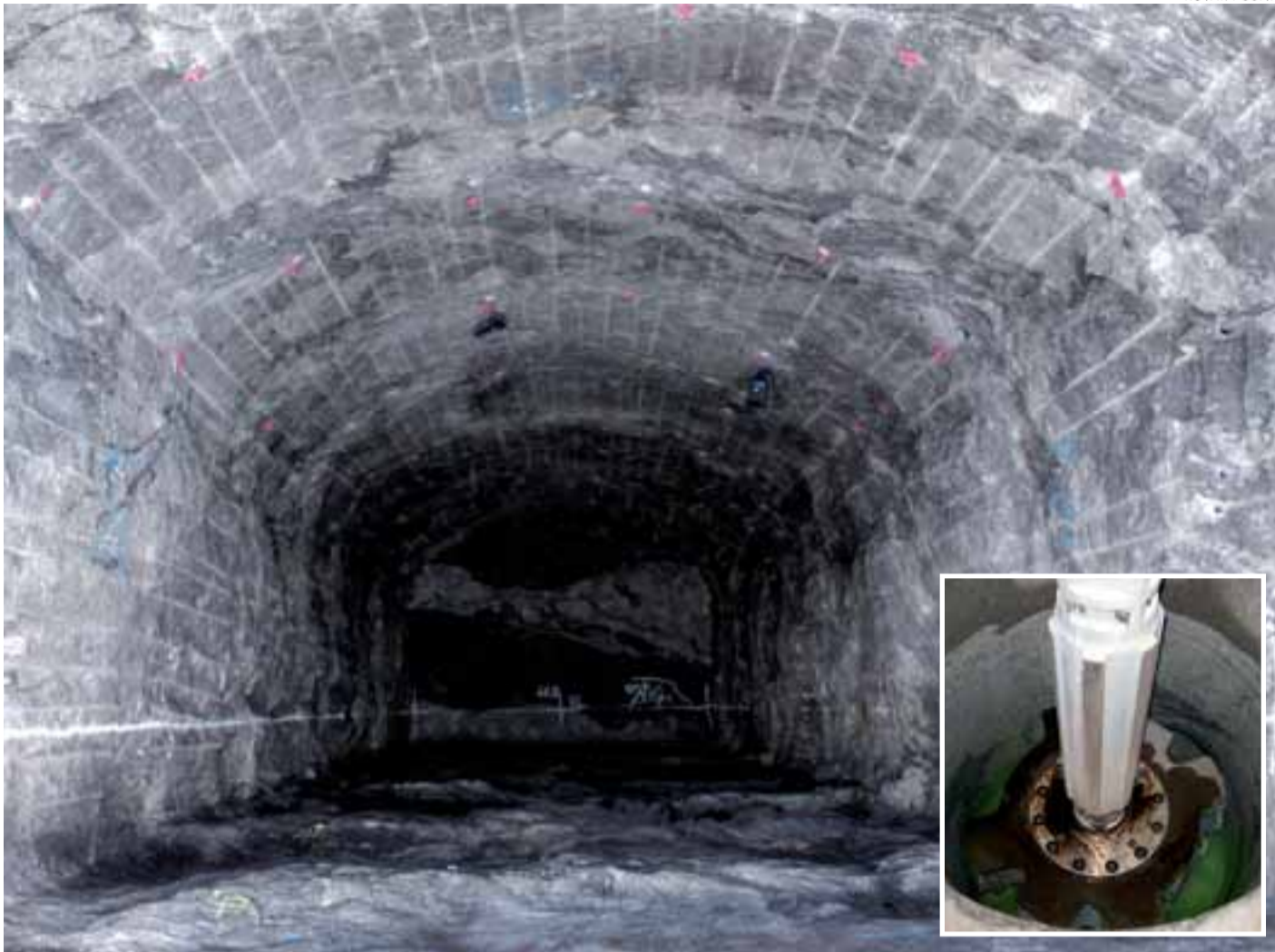
ONKALON tutkimustila 3 on laajennuksen jälkeen 7 metriä korkea ja 9 metriä leveä. Pikkukuvassa on hilseilytutkimuksessa käytettävä halkaisijaltaan 1,5-metrinen tutkimusreikä.
