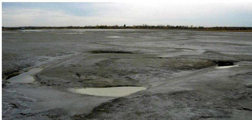
Рис. 1. Просідання та деформації поверхні соляно-глинистих відходів на денній поверхні секції № 1 Стебницького хвостосховища.
