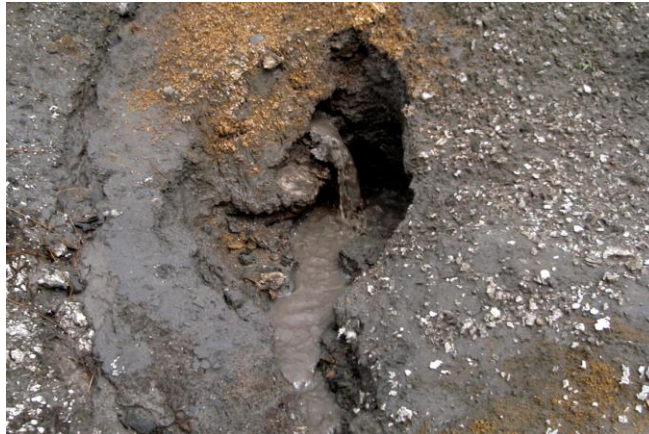
Рис. 7. Лінійно-ерозійний змив первинного гідроізоляційного прошарку з переходом глинистих мінералів у колоїдний розчин та винесенням за контур складування відвалів.
