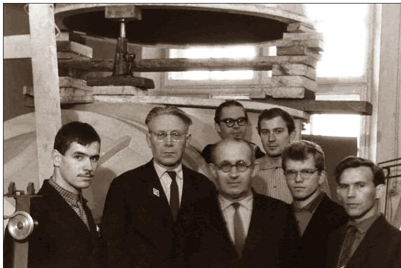
Монтаж аэродинамической трубы, 1964 г.
