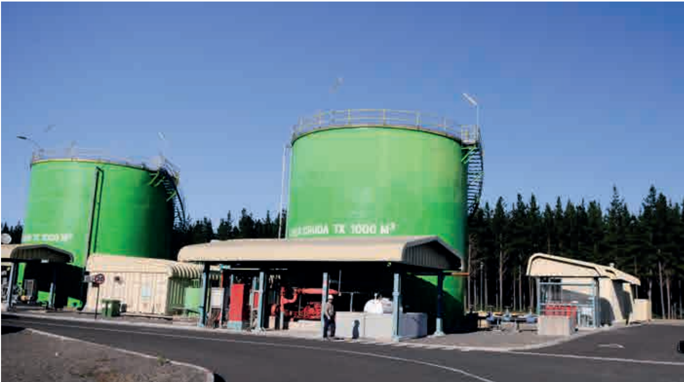
Los Pinos Power Plant
