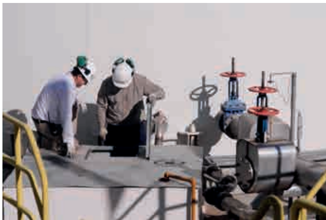
Los Pinos Station
