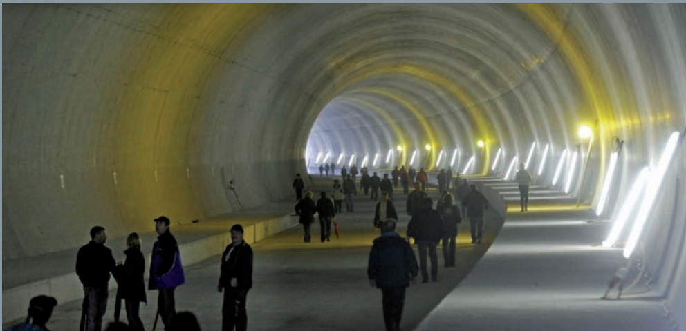
Tag der offenen Tür Tunnel Müß, Oktober 2010
