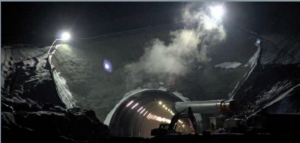
Tunnel Fleckberg, März 2012
