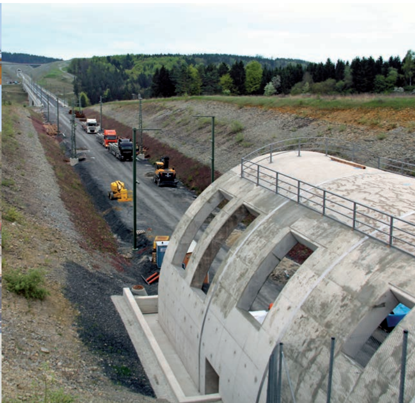
Südportal Tunnel Bleißberg mit Lärmschutzhauben 2014 Titel: Ilmtalbrücke Langewiesen längste Brücke Thüringens 2014
