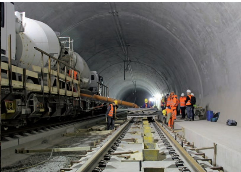
Bau der Fahrbahn im Tunnel 2015
