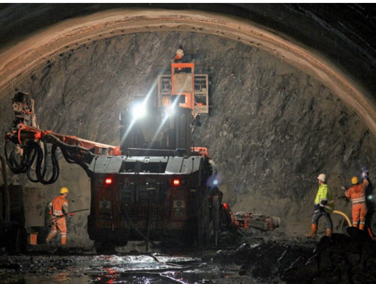
Vortriebsarbeiten an der Ortsbrust 2011
