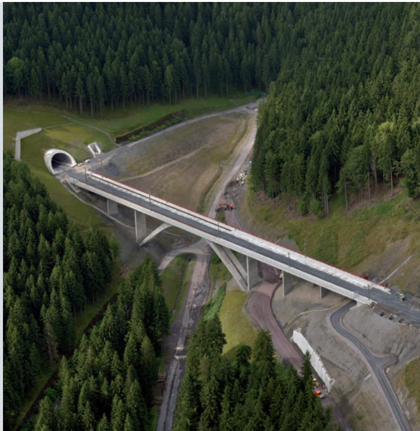
Integrale Konstruktion ohne Lager, Grubentalbrücke 2015
