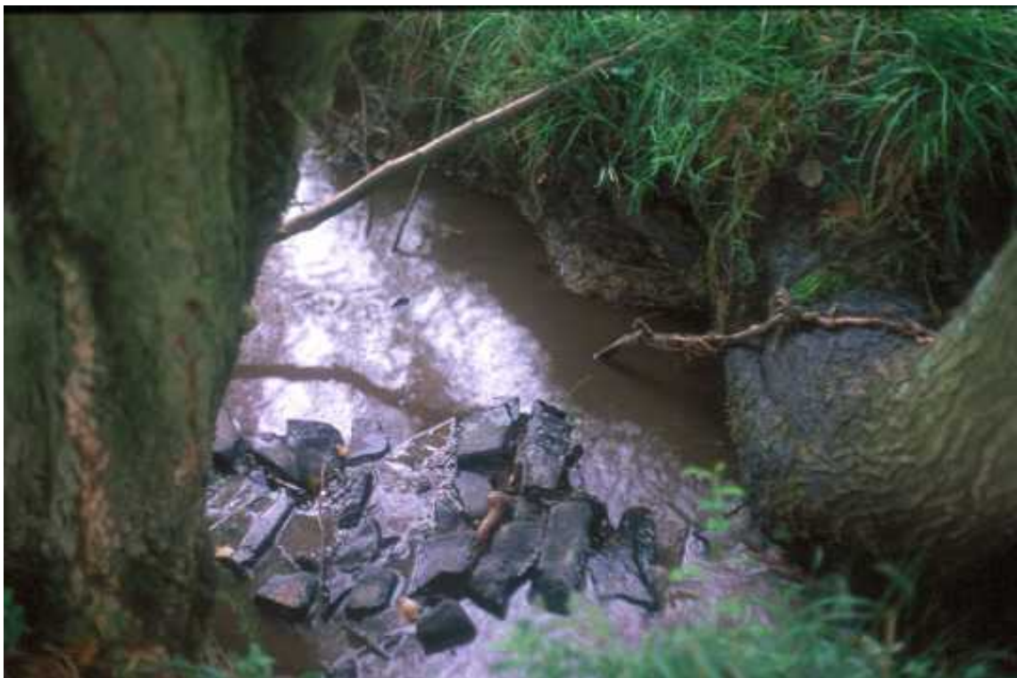
Abb. 4.50: Sohlenpflasterrest des ehemals vollständig ausgebauten Roßbaches
