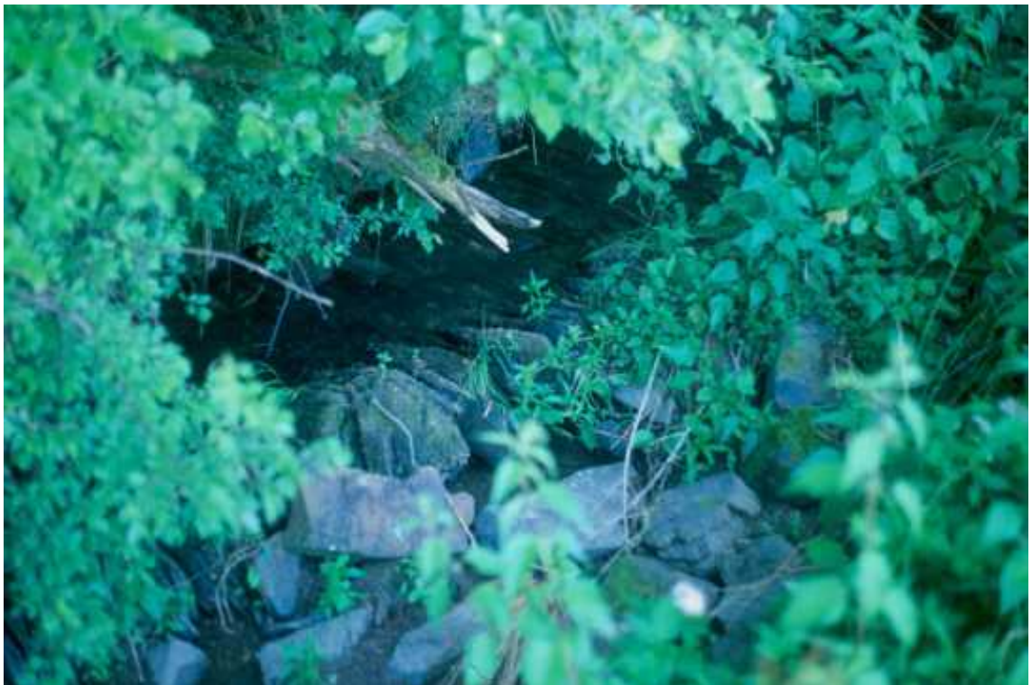
Abb. 4.86: Befestigte Sohle des Steinkratzbaches mit beginnender Breitenerosion
