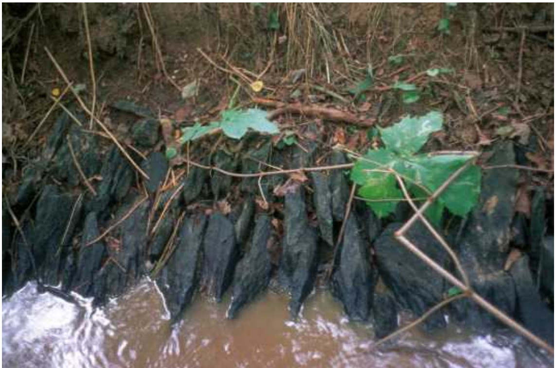
Abb. 4.115: Ufersicherung im Knallbach
