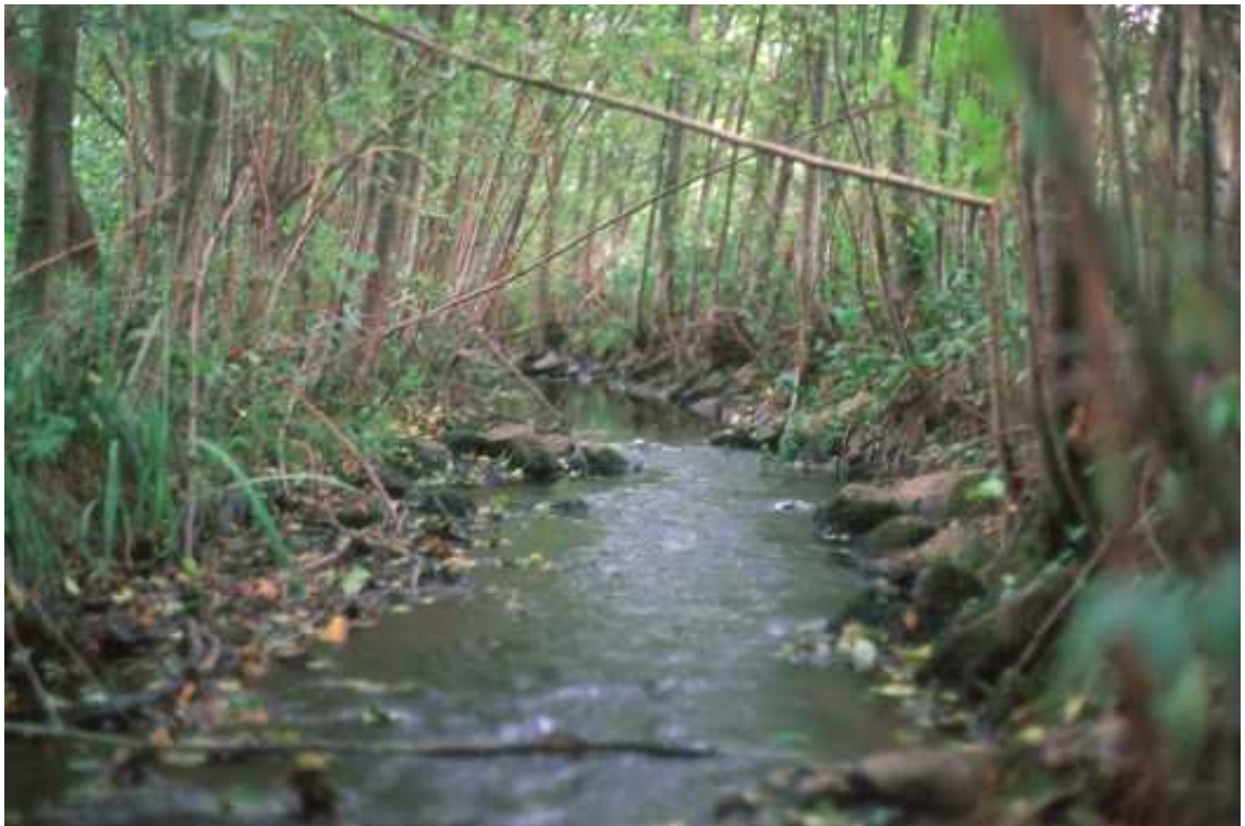
Abb. 4.27: Mit Steinschüttung befestigter Mündungsbereich des Mandelbaches
