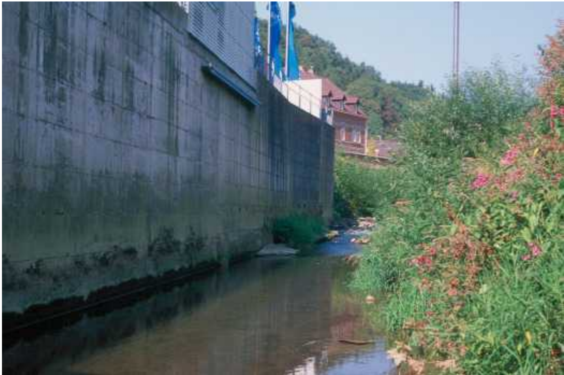
Abb. 4.25: Dietzhölzeunterlauf im Industrie- und Gewerbegebiet von Dillenburg
