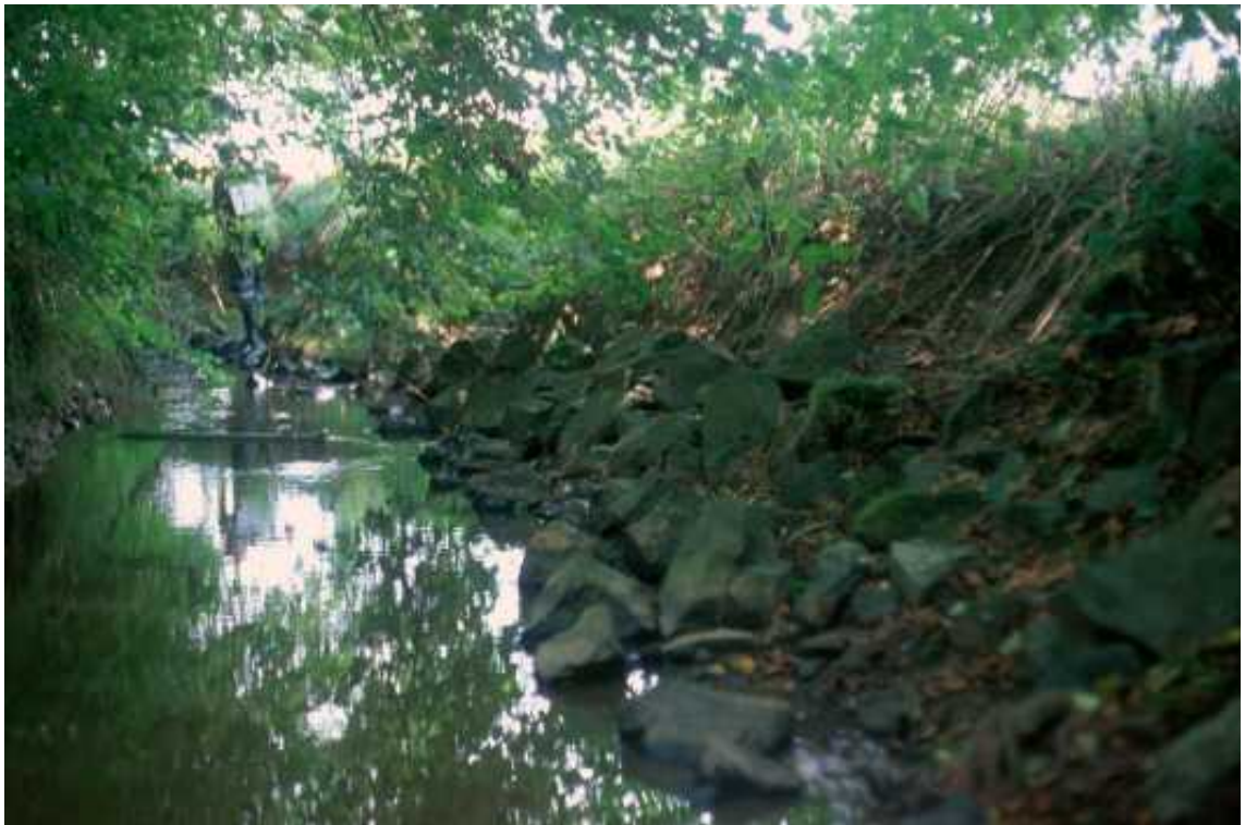
Abb. 4.127: Uferbefestigung im ehemals begradigten Lohbach
