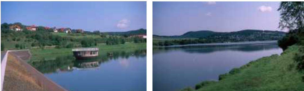
Abb. 4.38: Sperrbauwerk des Aartalsees ... und der See mit Blick auf Niederweidbach
