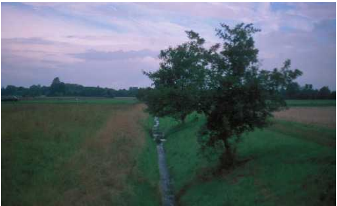
Abb. 4.15: Der Mündungsbereich des Surbaches ist als befestigter Graben ausgebaut
