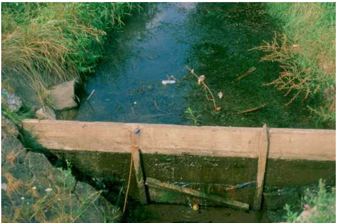
Abb. 4.8: Gepflastertes und aufgestautes Trapezprofil des Rechtenbaches
