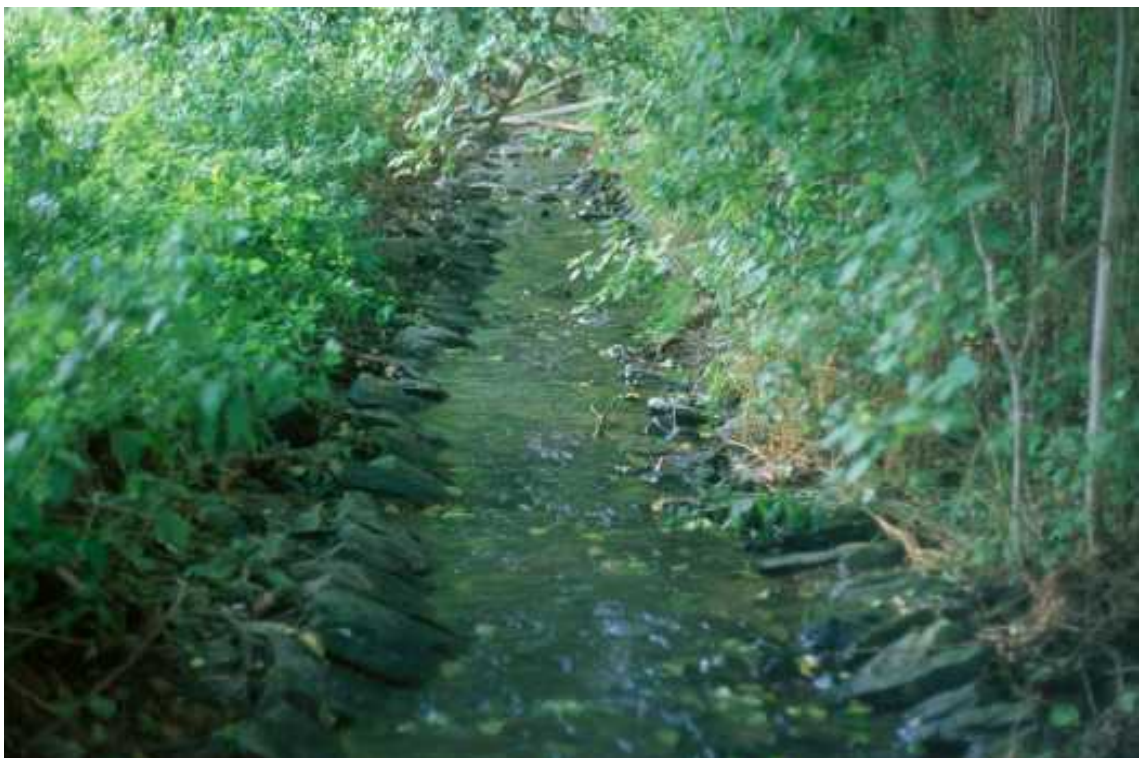
Abb. 4.79: Mit Steinsatz befestigter Abschnitt des Laubaches oberhalb Gemünden
