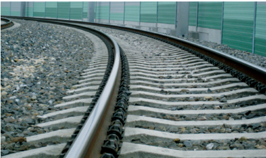
Abb. 11: Gleisbogen mit HD-Schwellen bei Sankt Pölten
