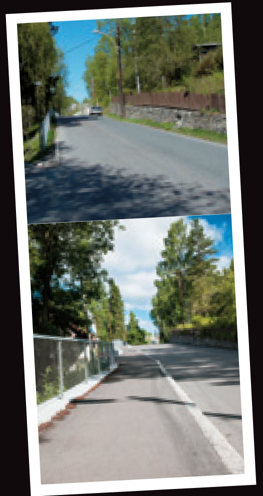
Fortau i Hukerveien / Pavement in Hukerveien
