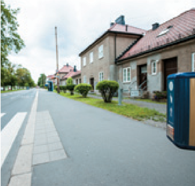
Nedsenket kant ved fotgjengerfelt / Dropped kerb at pedestrian crossing.
