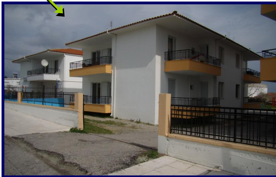
ΣΟΑ 6 Διαμερισμάτων επί οδού ΑΝΑΤΟΛΙΚΗΣ ΘΡΑΚΗΣ.
