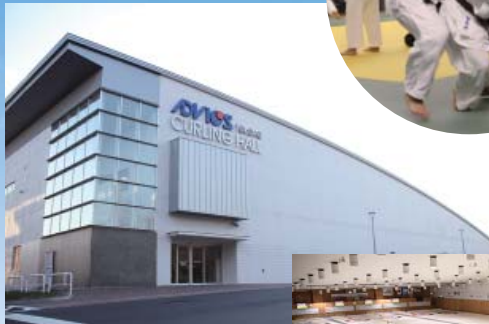
アドヴィックス 常呂カーリングホール
