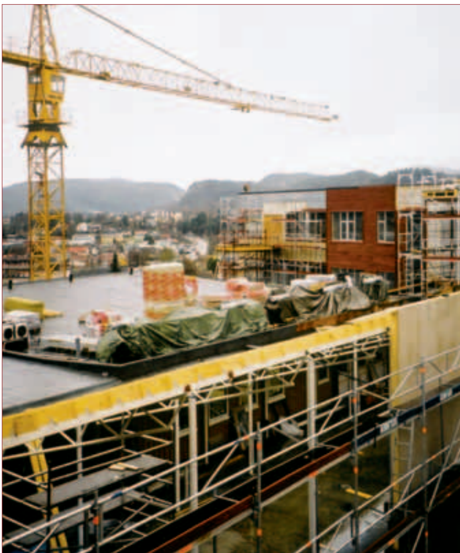
Bygget ved Olav Duun videregående skole skal stå ferdig til skolestart.
