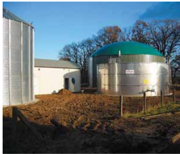
Biogas-Anlage in Iden: Energie für eine ganze Gemeinde
