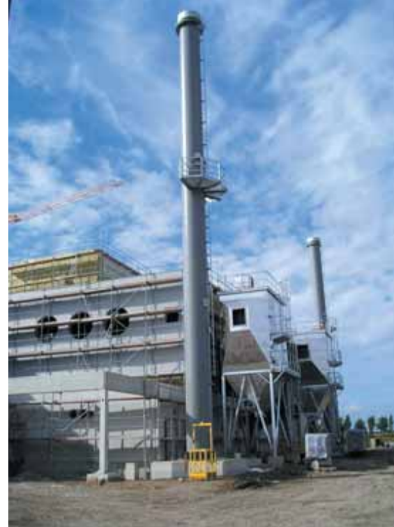
Das Biomasse-Heizkraftwerk Alperstedt im Bau
