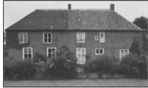
Afb. 2. De linkerzijgevel van het huis (zuidwestzijde), waarin duidelijke bouwsporen van diverse gedichte vensters (1981).
