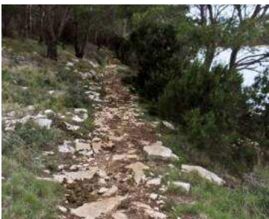
Slika 3. Postojeća staza na jugozapadnom dijelu jezera s rastresitim slojem manjeg kamenja (slikana s pozicije 9 označenoj na Slici 1.)
