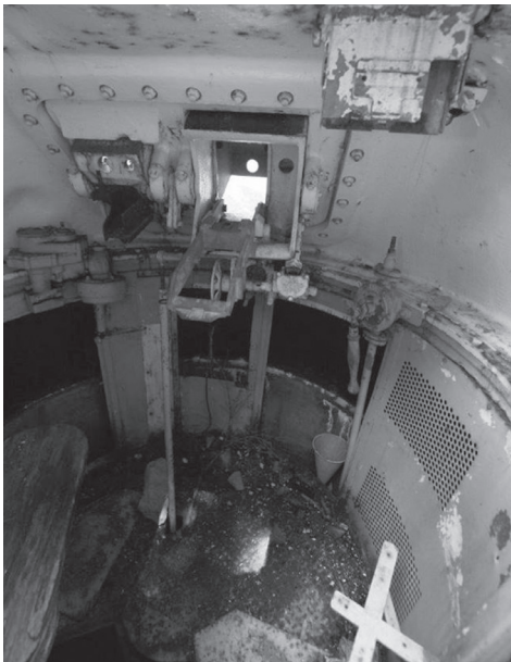
Der Blick ins Innere eines dieser Türme. In der Bildmitte die Mg-Lafette. © Christian Vaucher.
