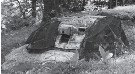
Staghound-Turm als Nahverteidigung der Panzertürme in Planaux im Raum der Festung St-Maurice.
