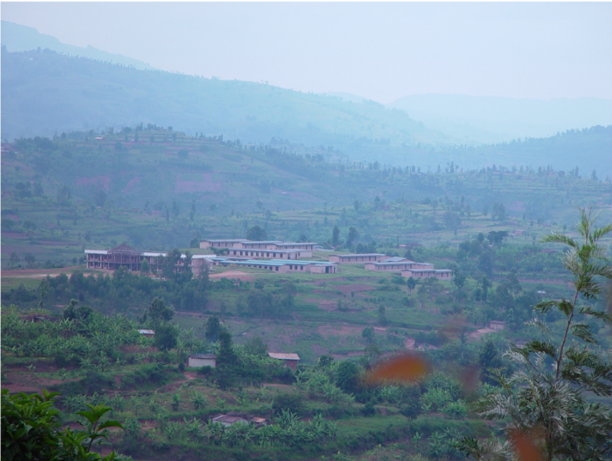
FIGURE 30.3 – Vue générale de l'école de Murambi (Gikongoro) après le génocide. On distingue le musée en construction devant le bâtiment à 2 étages. Source : DG
