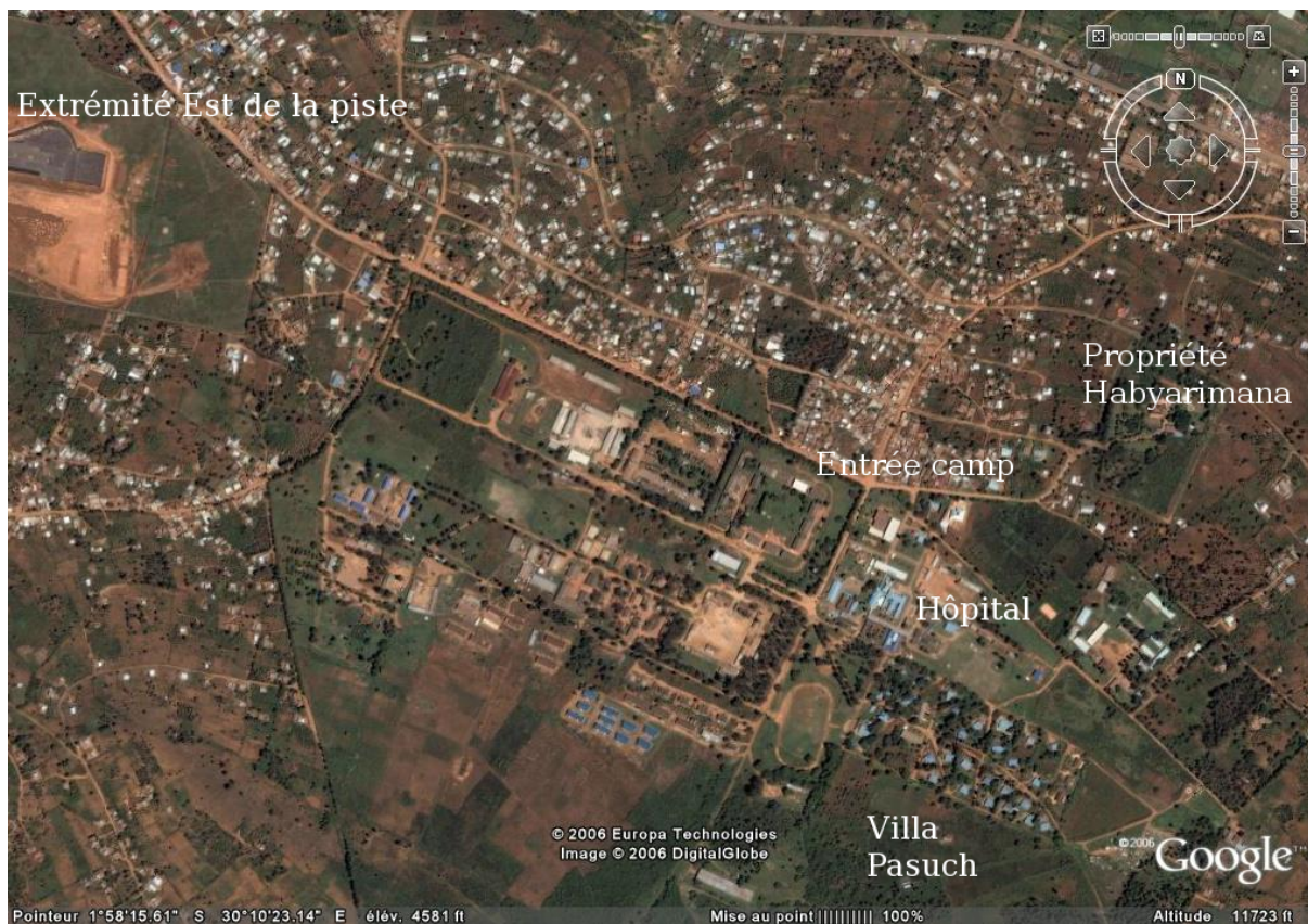
FIGURE 7.3 – Vue de l'extrémité est de la piste de Kanombe (en haut à gauche), du camp militaire de Kanombe (au milieu), de l'hôpital militaire (à droite du camp, au-dessus du stade), des villas dont celle du Dr Pasuch (en bas) et de la propriété Habyarimana (à droite). Le carrefour de Nyarugunga est au coin Nord-Ouest du camp. Source : GoogleEarth
