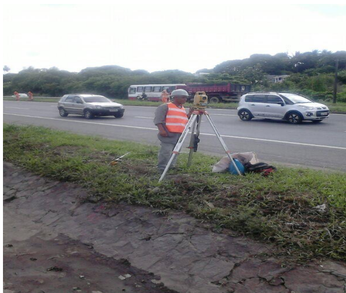
Figura 10 – Equipe em campo locando o eixo de projeto
