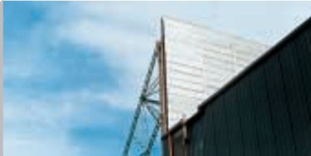
Schallschutzwand im Werk Pacheco
