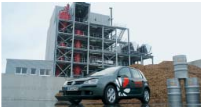
Inbetriebnahme des ersten Bauabschnitts der neuen Anlage im Oktober 2003
