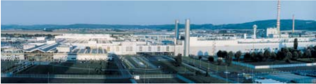
Škoda-Werk in Mladá Boleslav: neue Lackiererei (rechts im Bild)
