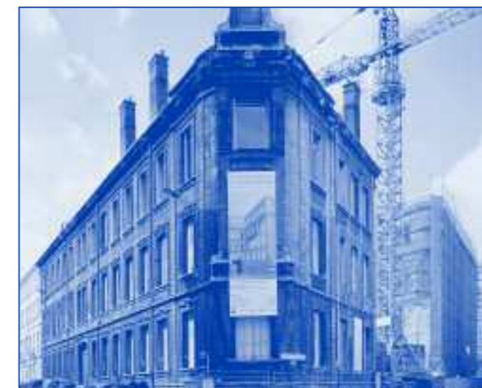
ENSA de Saint-Etienne - Pignon de la façade sud-est vue de la place Jacquard avant travaux - Photo Jean-Marie Monthiers ©
