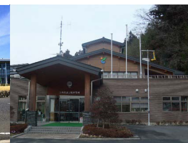
津山総合支所
