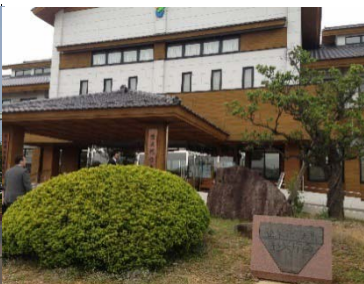
登米庁舎（登米総合支所）
