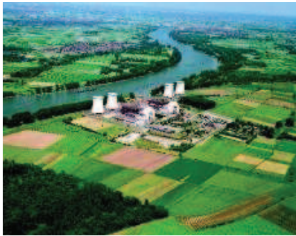
Kraftwerk Biblis, Foto: RWE Power Aktiengesellschaft
