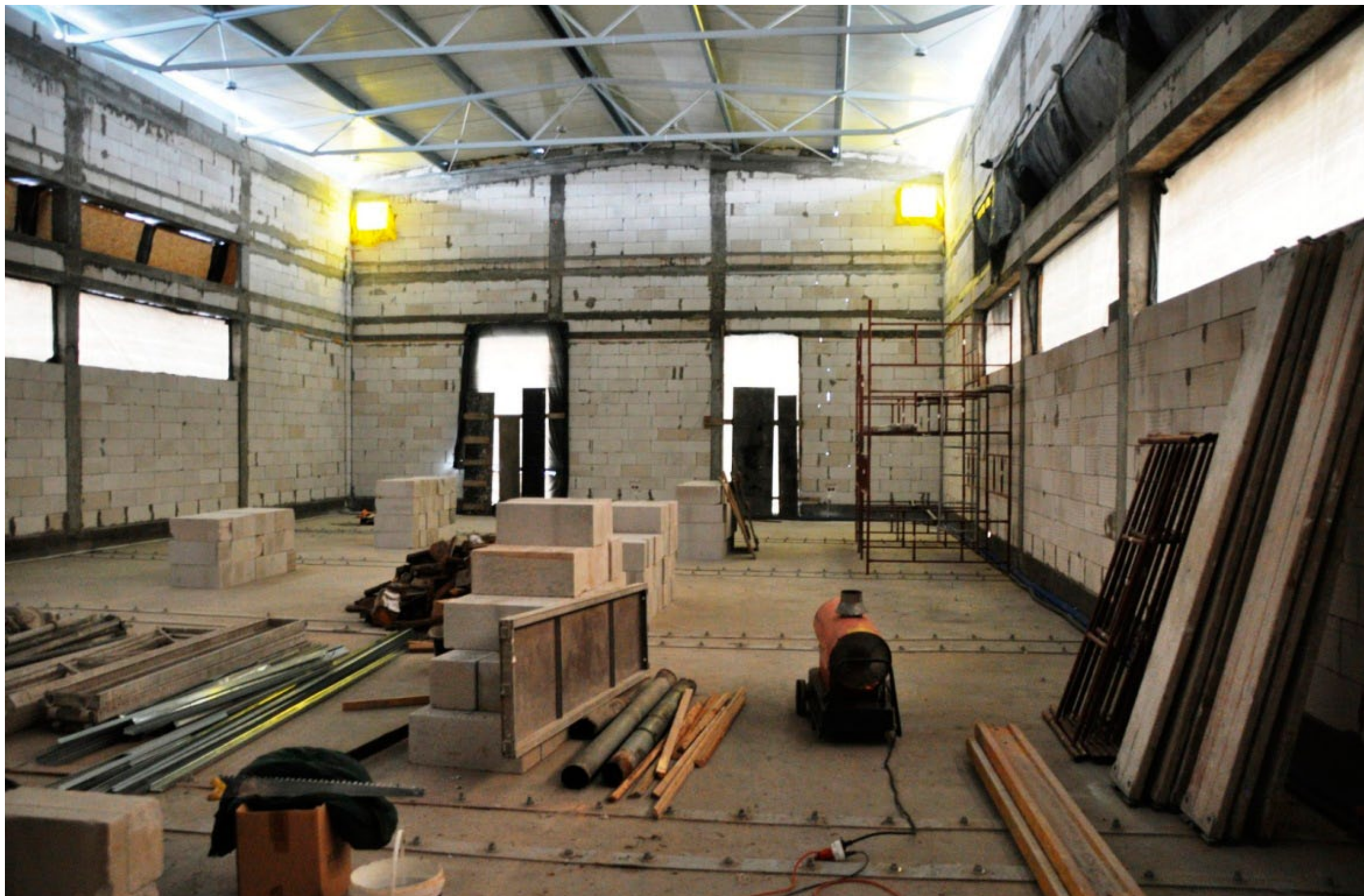
Równocześnie trwają prace na górnej sali gimnastycznej.
