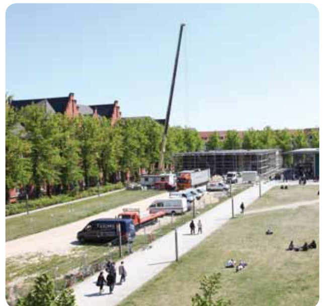
Baustelle Campus Ulmenstraße Construction site Ulmenstraße
