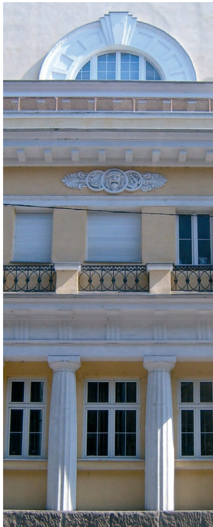
Сл. 3. Детаљ фасаде Руског дома, (фотографија М. Просен)
