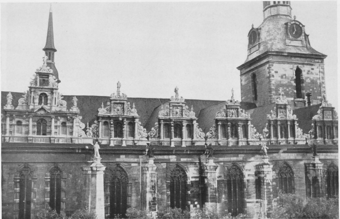
Abb. 16. Hauptkirche, Nordseite, Ausführung
