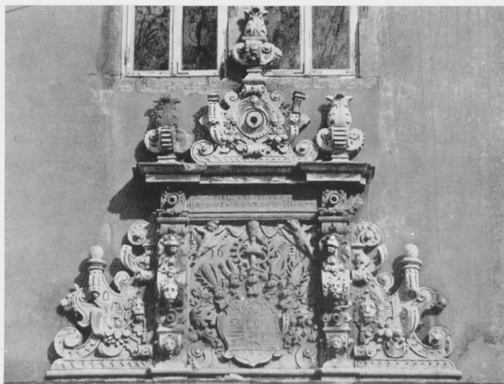
Abb. 3. Zeughaus, Westseite, Portalbekrönung
