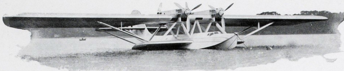
Le Latécoère 300 quadrimoteur Hispano-Suiza 650 CV 12 Nbr est destiné aux liaisons transatlantiques.
