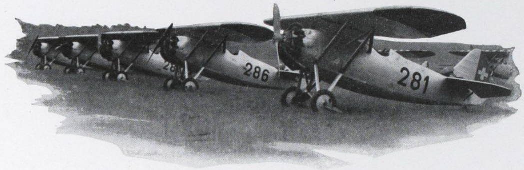
Le Dewoitine moteur Hispano-Suiza à air 250 CV 9 Qa fabriqué en grande série pour l'aéronautique suisse.
