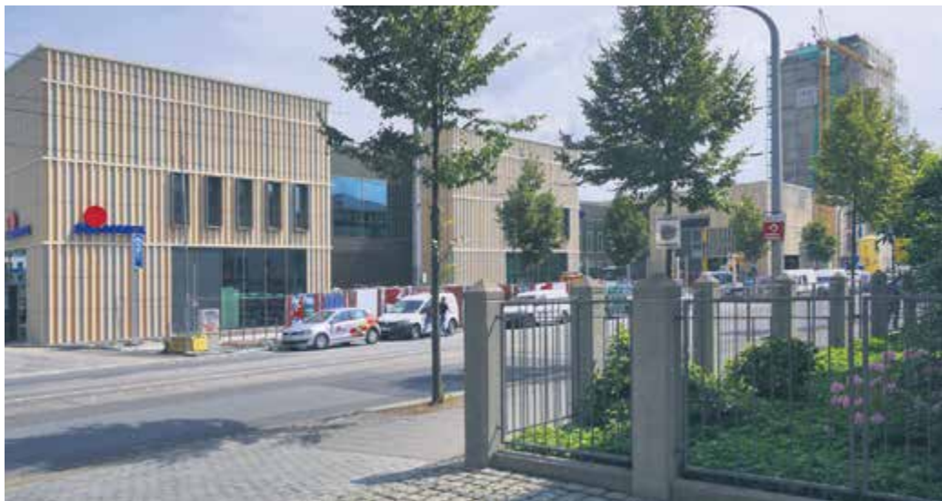
WÄHREND AM 2. JULI das neue Einkaufszentrum an der Antonstraße öffnet, dauert die Sanierung des denkmalgeschützten Hochhauses voraussichtlich noch bis zum Herbst. Foto: Bäumler
