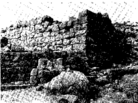
Abb. 6: SÜDOSTECKE DES 'PYRGOS'- FUNDEMENTS. DAVOR RESTE DER STADTMAUER.
