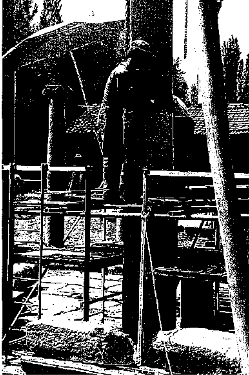
Abb. 5: Aizanoi 1995, Restaurierungsarbeiten an der Säulenstraße
