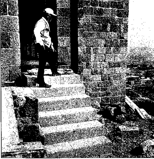
Abb. 3: Bau Z. Treppe an der Westseite Resim 3: Z yapısı. Batı taraftaki basamaklar
