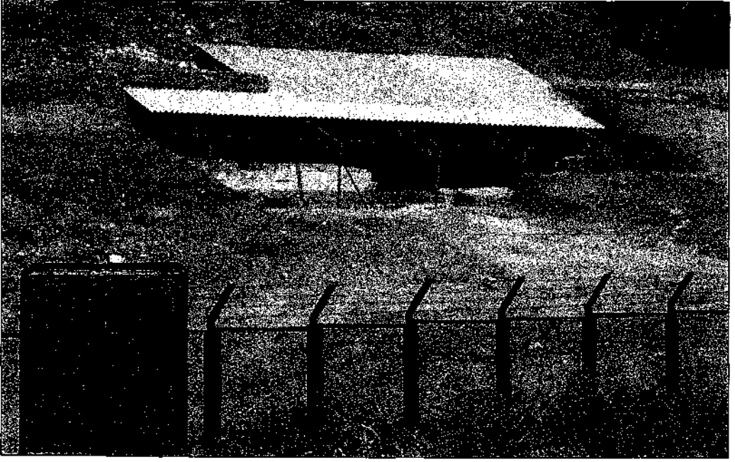
Resim 3: Pers Teras Suru üzerine yapılan koruma çatısı
