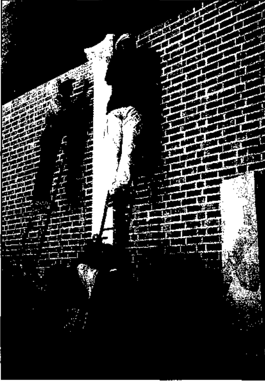
Abb. 9: Bau Z. Montage der Stuckwand im Maskenmosaikraum
