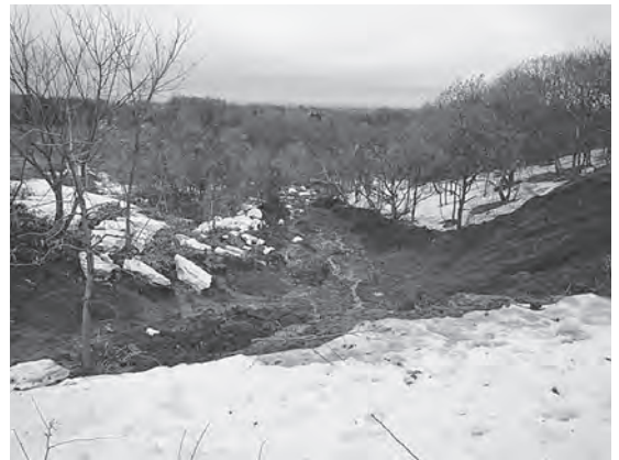
大平地区農地法面崩落状況 (0.05ha)
